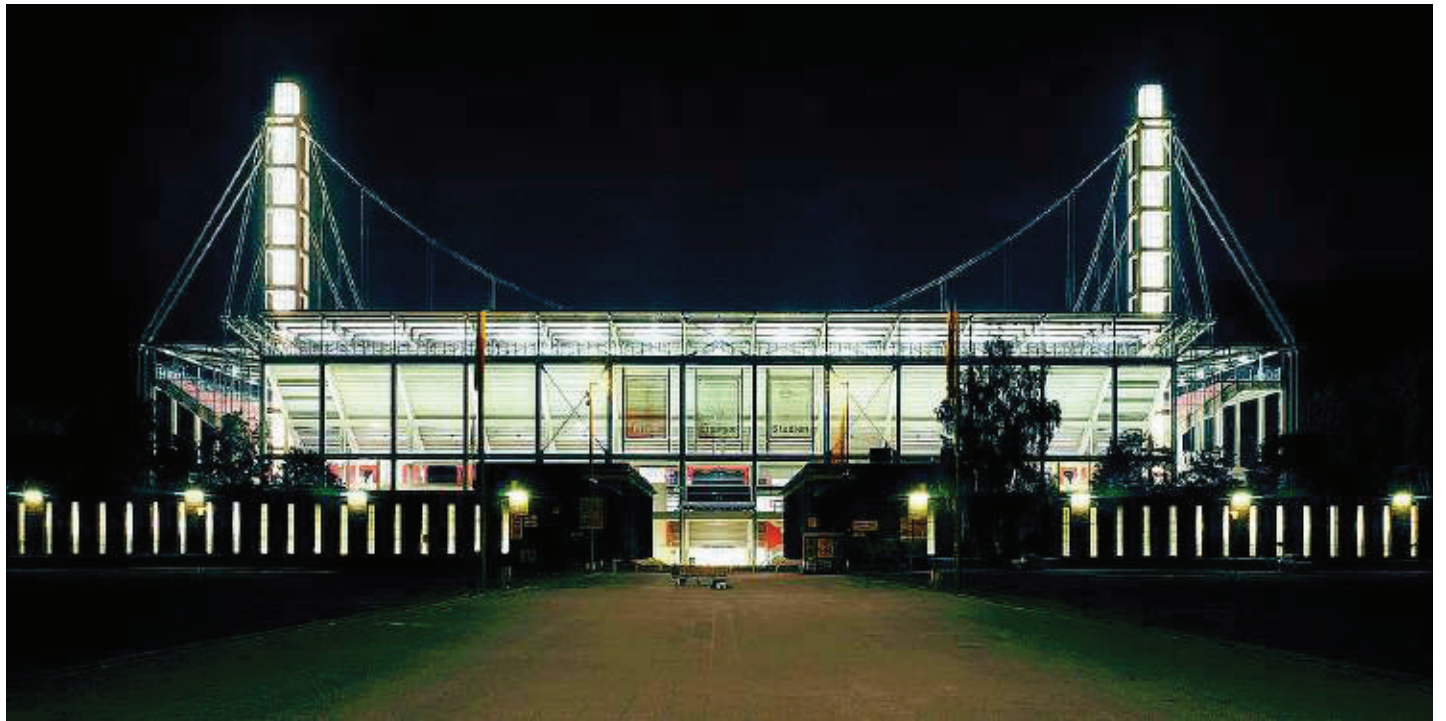
Die Pylone des Stadions sind als Lichtobjekte konzipiert. Doch Bürger wollen die Beleuchtung aus Sparsamkeit lieber ausknipsen. BILD: RHEIN-ENERGIE
